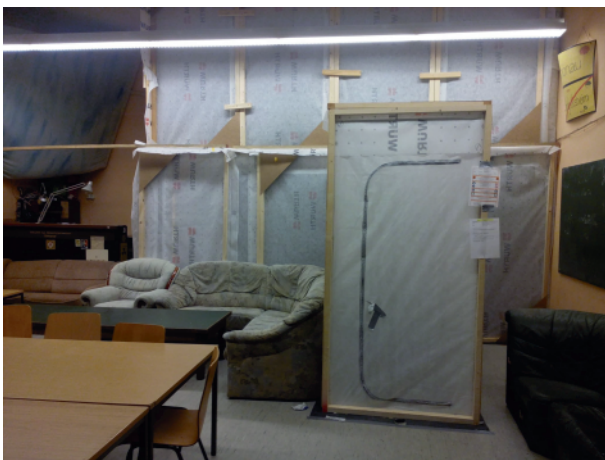
Staubschutzwand im EB104.
